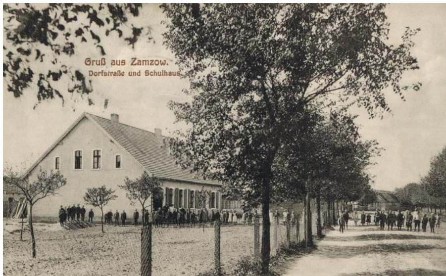
Dorfstraße und Schulhaus
